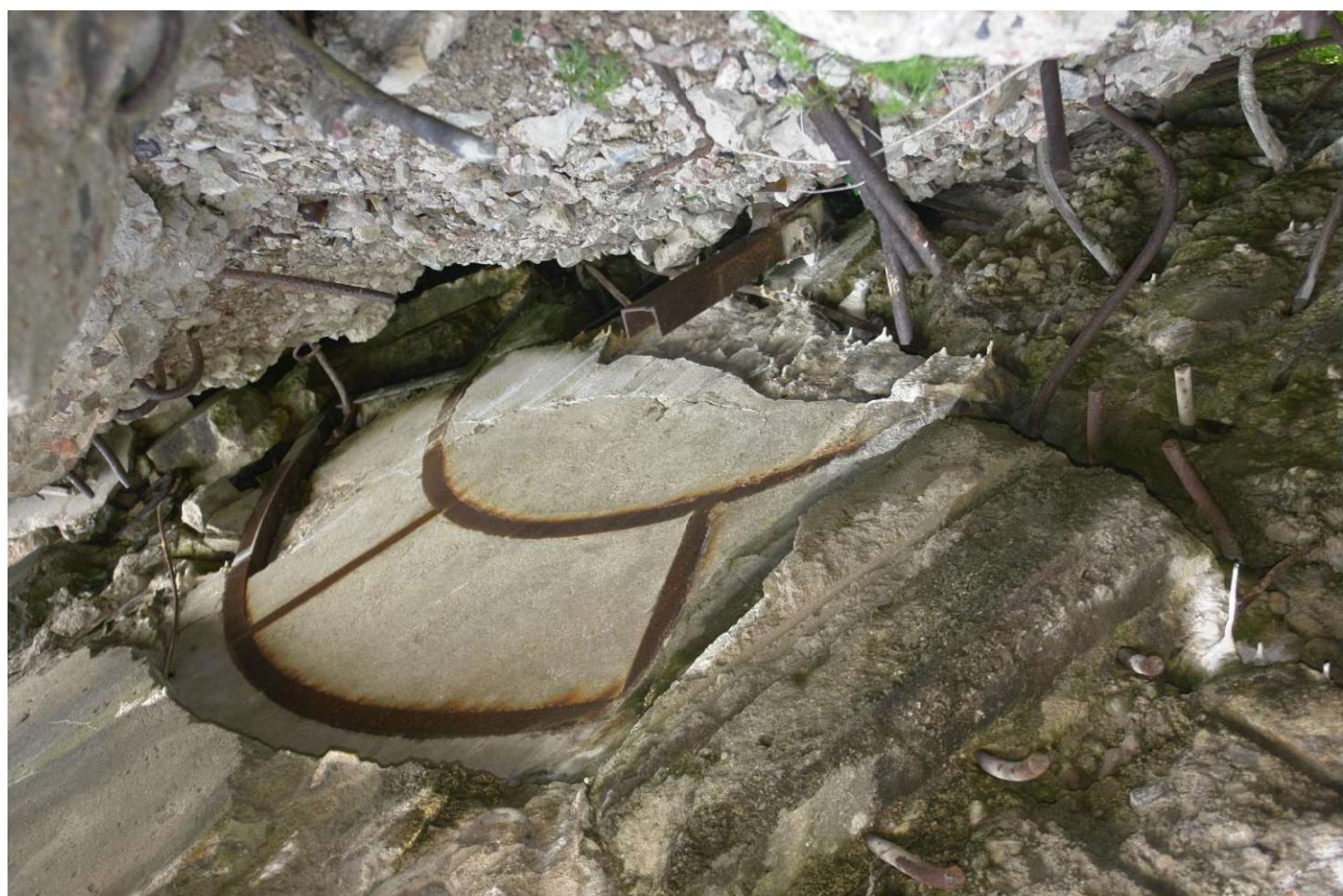
Stanowisko armaty 75 mm w tradytorze artyleryjskim z 1939 roku wybudowanym na terenie Twierdzy Osowiec. Schron został wysadzony przez Niemców jesienią 1944 r. Jest trwałą ruiną i leży stropem na gruncie. Dla lepszego zobrazowania zdjęcie obrócono o 180 stopni.
