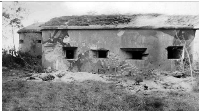
Zbliżenie na elewację tradytora na prawym barku. Widoczny wylot lufy armaty polowej, wnęka na celownik dla armaty ppanc. oraz ślady ostrzału.
