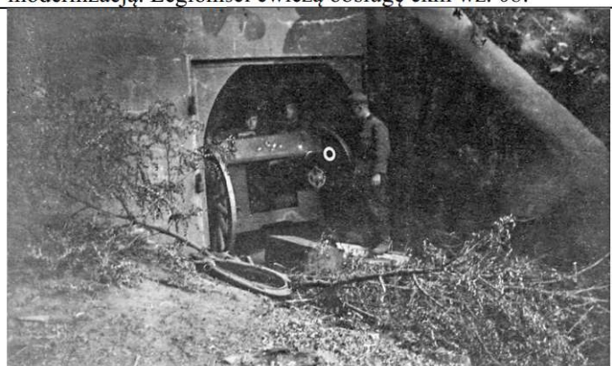
Armata wz. 02 na stanowisku w podwalni/przelotni. Na górnej tarczy widoczne przestrzeliny. Na elewacji tradytora nowy kamuflaż z 1938 r.
