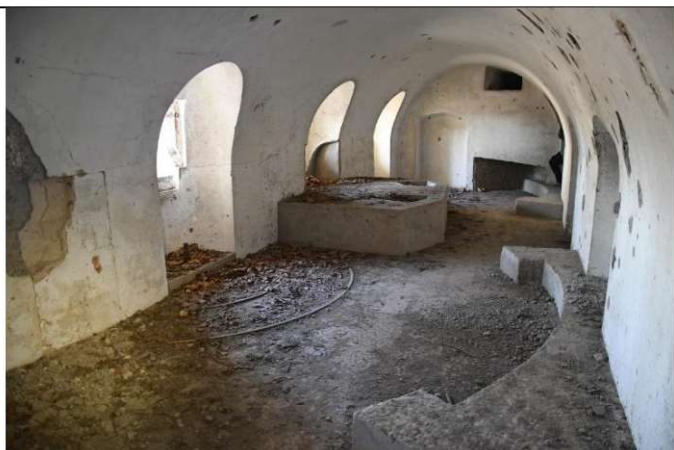
Widok wnętrza zmodernizowanej izby tradytora. Na pierwszym planie stanowisko przystosowane do armaty polowej 75 mm, następnie postument dla armaty 37 mm, potem kolejne stanowisko armaty 75 mm.
