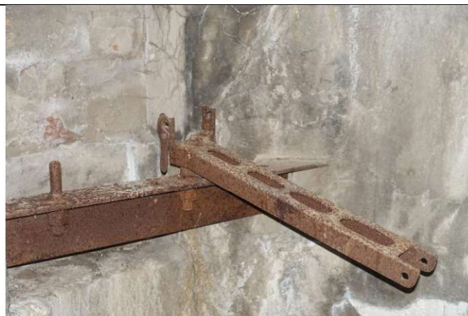
Stanowisko przystosowane do montażu ciężkiego karabinu maszynowego. Zachowana dolna część podstawy fortecznej.
