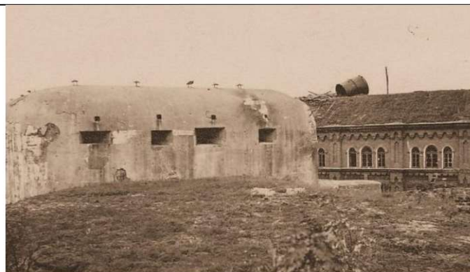
Widok wschodniej elewacji tradytora ze strzelnicami zmodernizowanych stanowisk.
