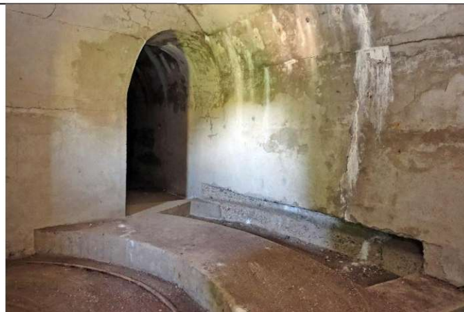
To samo stanowisko do armaty polowej 75 mm. Widoczna nadlewka podłogi dla obsługi i wnętrza pod lemesz ogona armaty.
