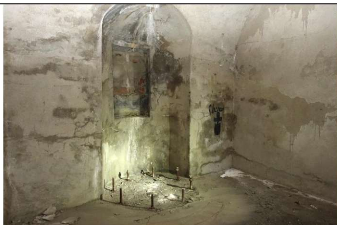
Oryginalne stanowisko do montażu armaty 87 mm na podstawie fortecznej. Widoczny wieniec szpilek gwintowanych oraz ślizg dla rolki. Poniżej widok wzmocnienia wieńca od spodu stropu na dolnej kondygnacji.
