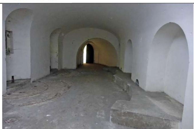
Widok wnętrza zmodernizowanej izby prawego tradytora. Dwa stanowiska przystosowane do armat polowych 75 mm Szpilki mocujące oryginalną rosyjską podstawę forteczną zagięte podczas modernizacji. Szyny prowadzące zostały zdemontowane w nieznanych okolicznościach.
