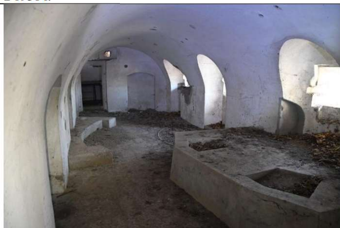
Widok izby w przeciwnym kierunku. Na pierwszym planie postument dla armaty 37 mm, stanowisko armaty 75 mm, stanowisko ckm.
