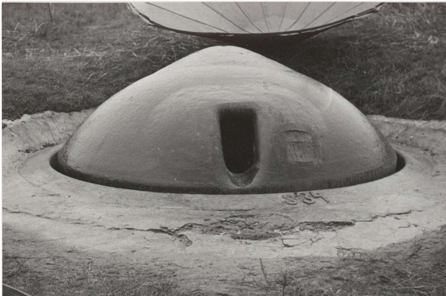
Wieża pancerna Skoda zainstalowana na forcie XVI. Widoczny numer seryjny S34.
