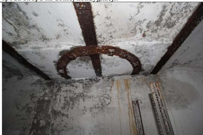
Oryginalne stanowisko do montażu armaty 87 mm na podstawie fortecznej. Widoczny wieniec szpilek gwintowanych oraz ślizg dla rolki. Poniżej widok wzmocnienia wieńca od spodu stropu na dolnej kondygnacji.
