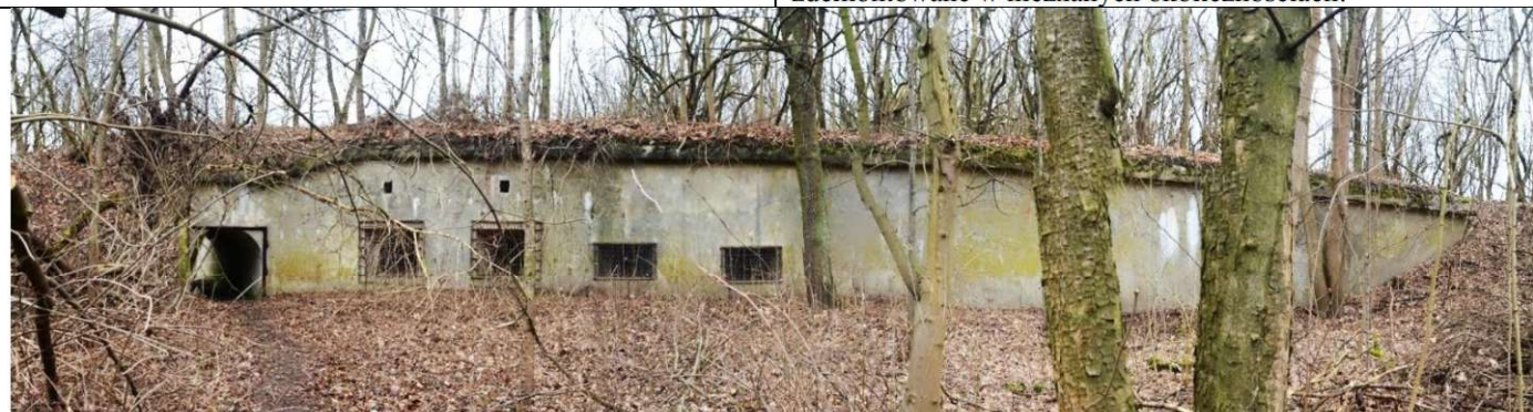
Widok panoramiczny elewacji tradytora na prawym barku. Dwie większe strzelnice zostały przystosowane przez rozkucie dla uzyskania większego kąta podniesienia lufy armat polowych 75 mm.
