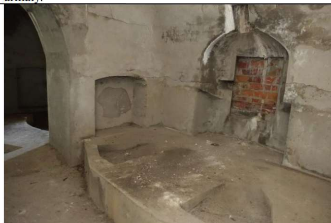
Betonowy postument dla armaty przeciwpancernej 37 mm.
