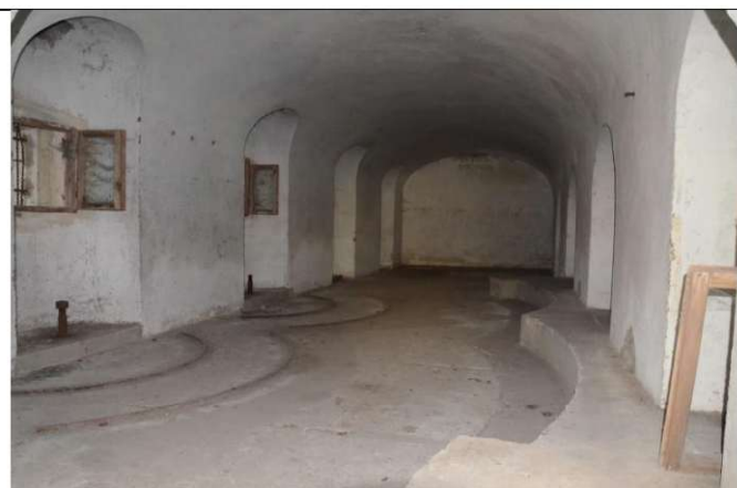
Widok wnętrza zmodernizowanej izby lewego tradytora. Dwa stanowiska przystosowane do armat polowych 75 mm.
