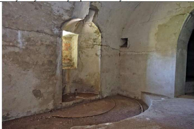
Zmodernizowane stanowisko przystosowane do armaty polowej 75 mm. Widoczna oś obrotu i szyny dla rolek podestu.
