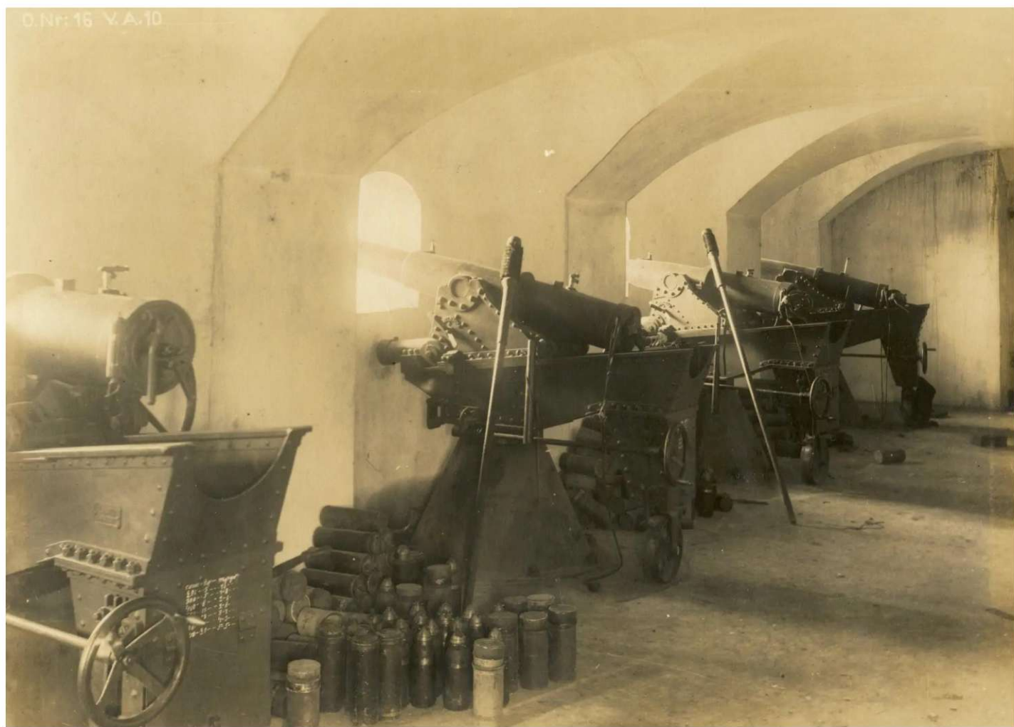
Izba bojowa standardowego rosyjskiego tradytora starego typu. Uzbrojenie stanowią 4 armaty 87 mm wz. 95 na podstawach fortecznych Durlachera wz. 95.
